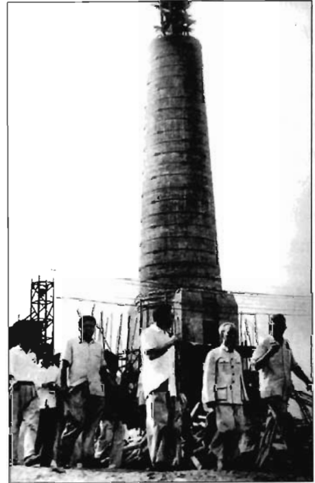
Chủ tịch Hồ Chí Minh thăm công trường xây dựng Nhà máy điện Vinh, tỉnh Nghệ An (6-1957)
