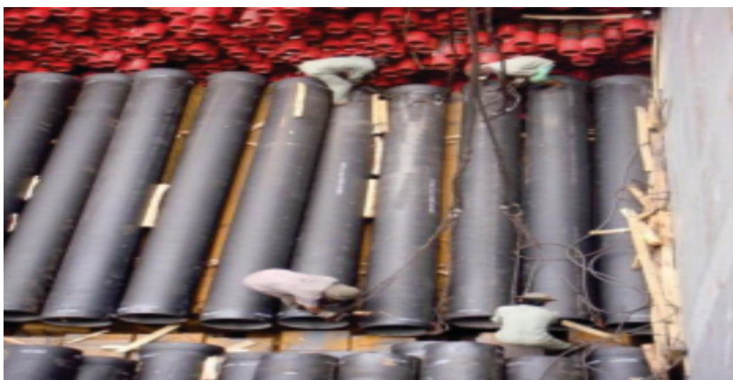
Hình 3.9: Quá trình lắp móc của công nhân (Nguồn :VNL)
