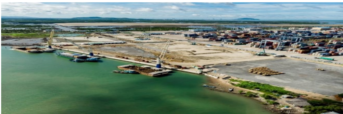
Hình 1. 5 Giai đoạn sửa chữa cảng Hưng Thái
