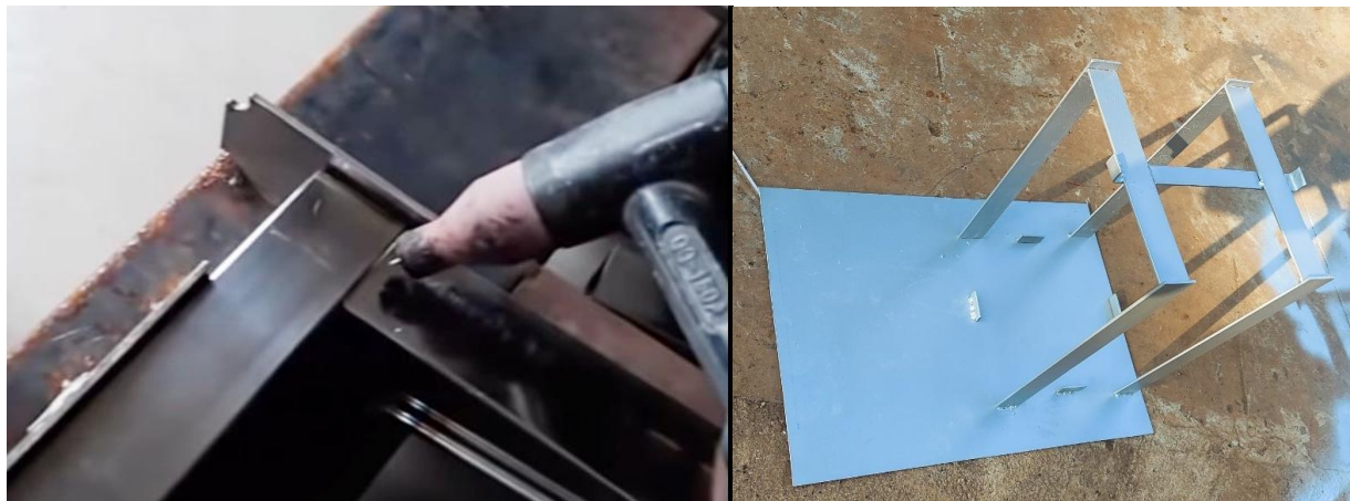
Hình 20 – Gia công kết cấu khung cơ khí
