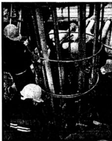
Hình 3.30 Ống siêu âm bằng nhựa (chi dùng khi lồng thép đặt suốt chiều dài cọc)
