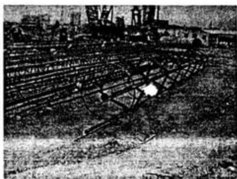
Hình 3.29 Ống siêu âm bằng thép
