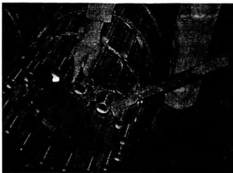
Hình 3.24 Nối cốt thép bằng ống ren (coupler)
