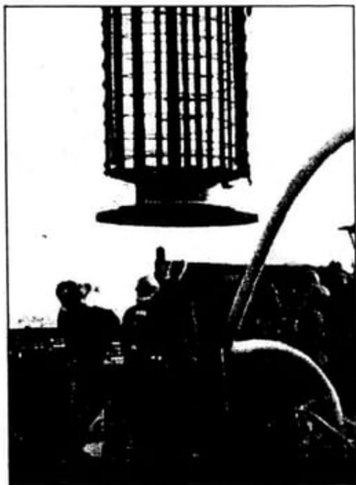
Hình 6.19 Lắp đặt hộp Osterberg
