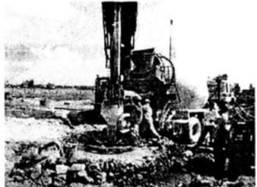
Hình 3.32 Rút ống trong quá trình đổ bê tông cho cọc nhồi
