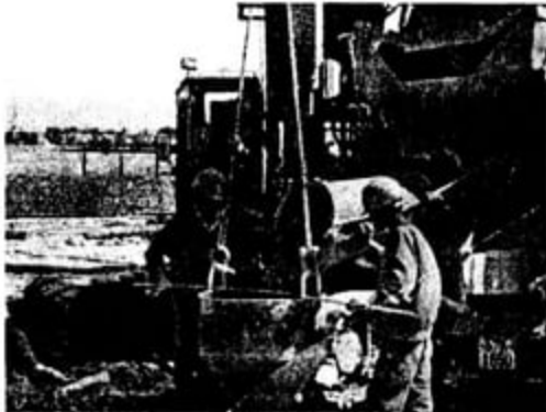
Hình 3.31 Đổ bê tông
