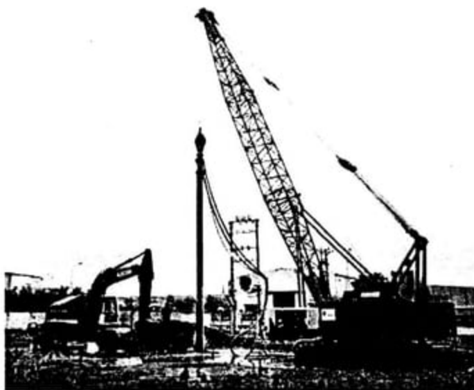
Hình 3.2 Thi công cọc khoan nhồi
