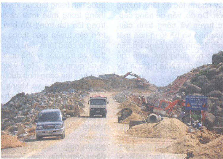
Xây dựng tuyến đường Phước Tân - Bãi Ngà dài 12,5 km, vốn đầu tư hơn 106 tỷ đồng, là một trong những công trình phát huy nội lực của Phú Yên
