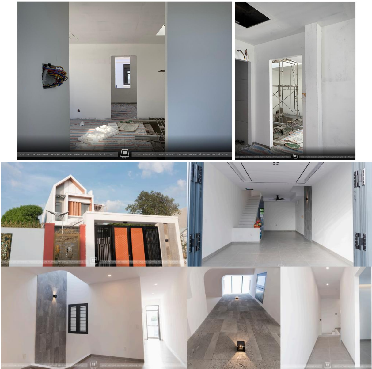
Hình 3. 6 Xây dựng phần hoàn thiện
