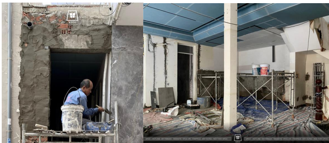
Hình 3. 2 Xây dựng phần thô
