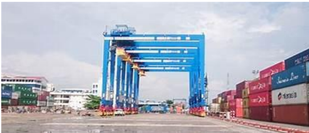
Hình 2. 1: Cầu bãi RTG 6+1: 10 cái
