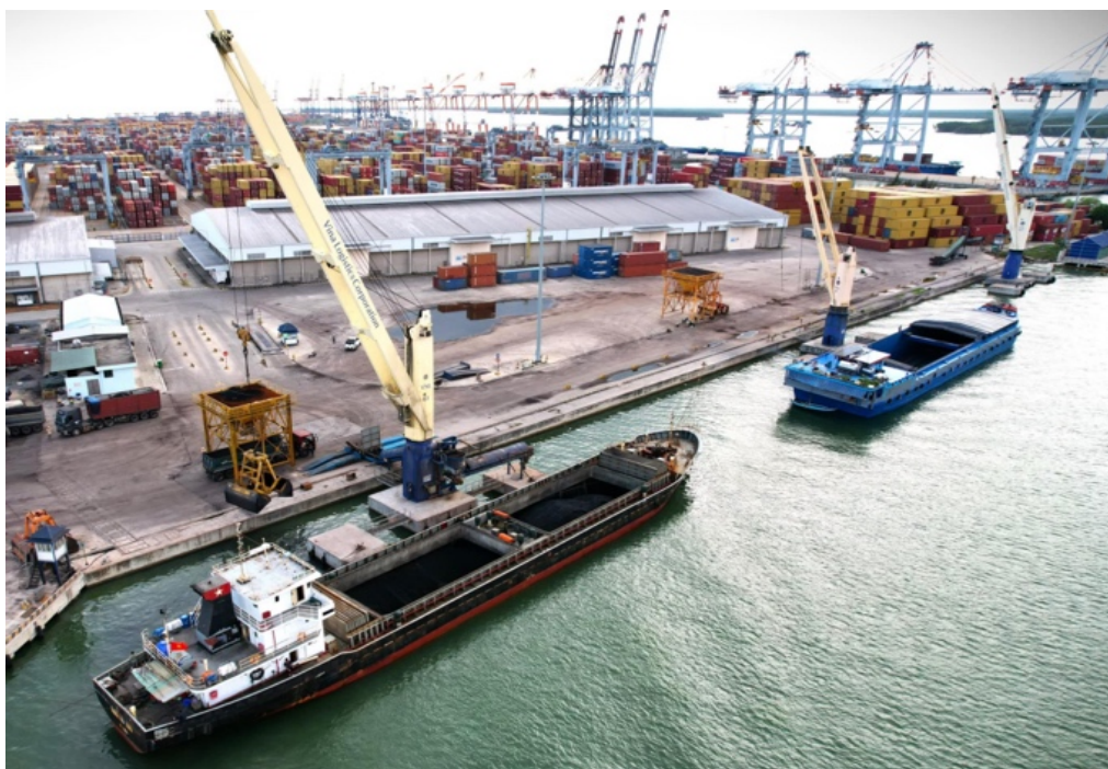
Hình 2.6. Nhà kho Công ty Cổ phần Vinalogistics
