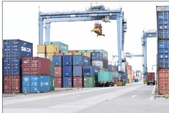
Hình 2.5. Cầu khung Rubber Tie Grantry
