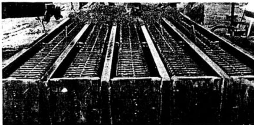
Hình 2.4 Các chi tiết thép trong cọc trước khi đổ bê tông
