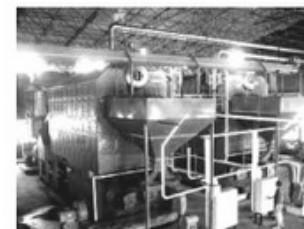
Hình 16.5. Nồi hơi đốt trấu, mùn cưa
