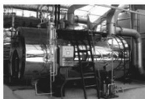
Hình 16.7. Nồi hơi thu nhiệt
