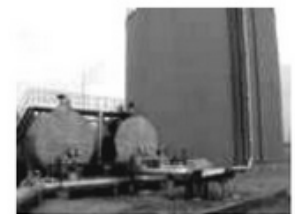
Hình 16.6. Nồi dầu tải nhiệt
